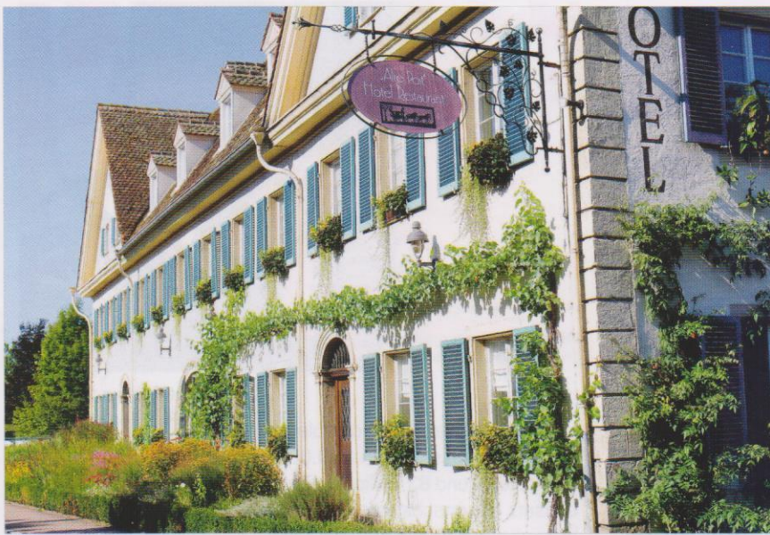
Die Hauptfassade des Landhotels „Alte Post“ in Müllheim.
